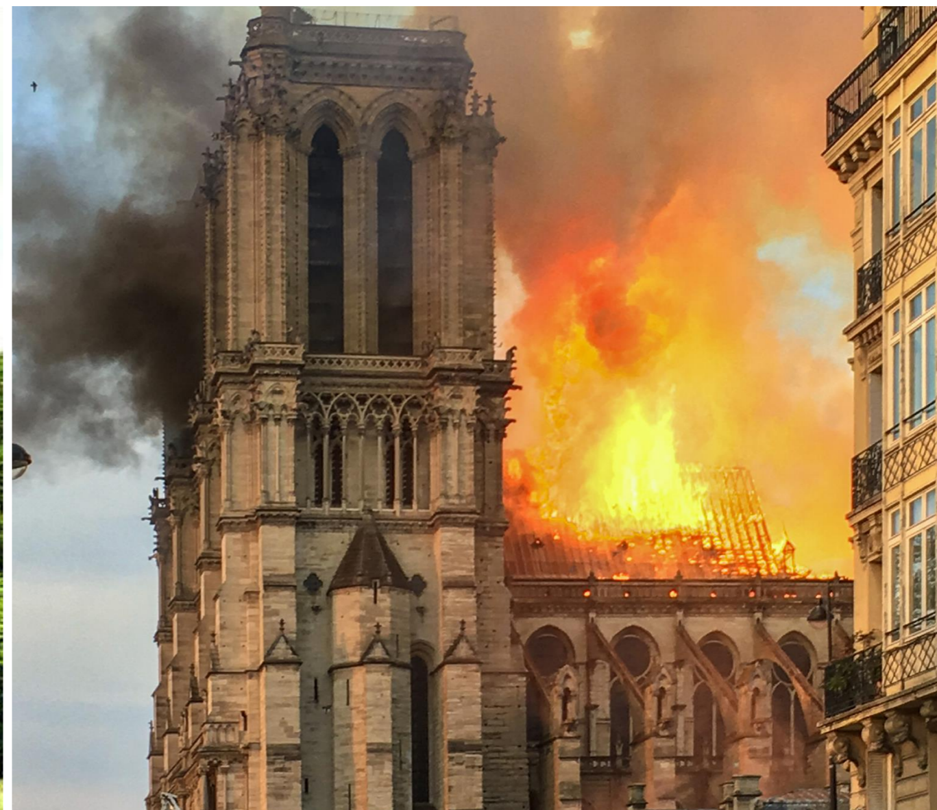
Поврежденный пожаром Нотр-Дам-де-Пари, Париж, Франция
