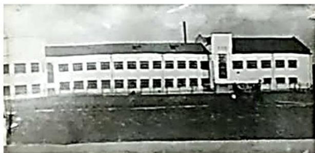
Эвакогоспиталь № 3747 г. Первоуральск (в здании школы)
